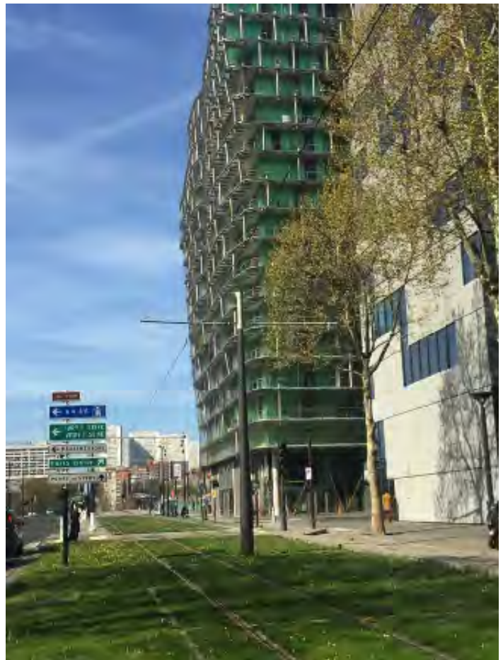
Paris 13ème, boulevard du général Jean Simon - Les plateformes enherbées du tramway viennent se substituer aux espaces de circulations et de stationnement automobile recouverts d'enrobé de bitume. La « tour de la biodiversité » de l'architecte Edouard François dispose en façade de tubes de plantations et de grillages sur lesquels les vignes vierges viendront se développer.
